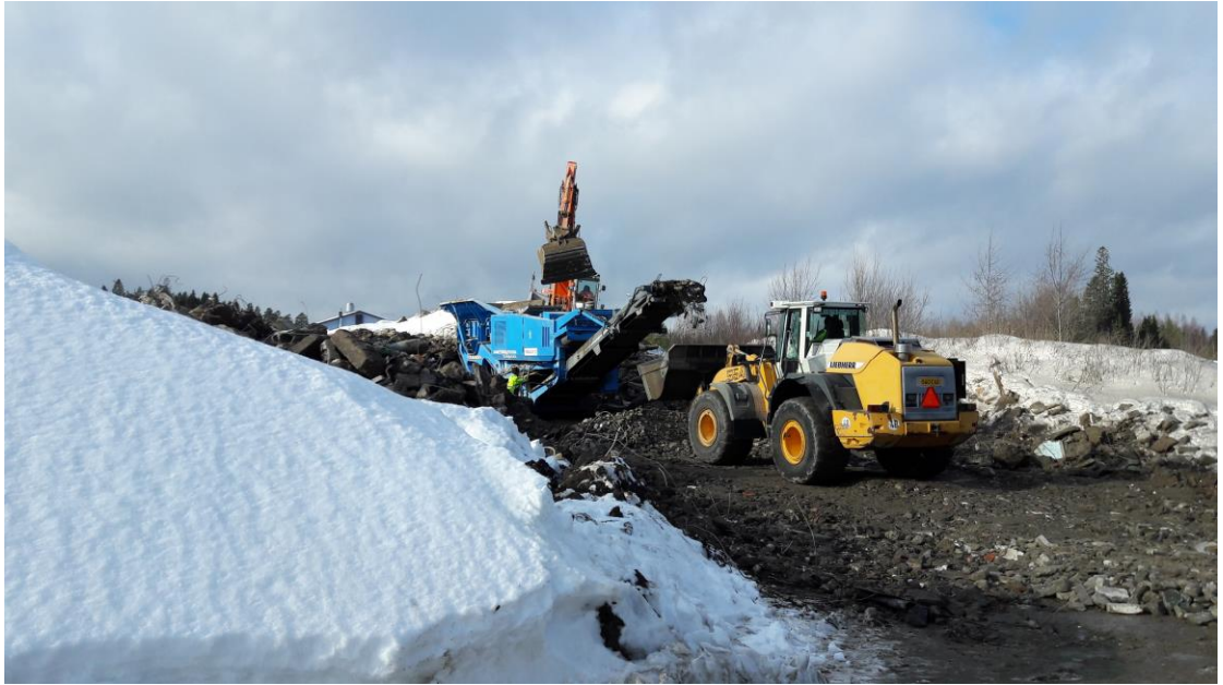
Kuva 2 Betonin murskaus ja keräys
